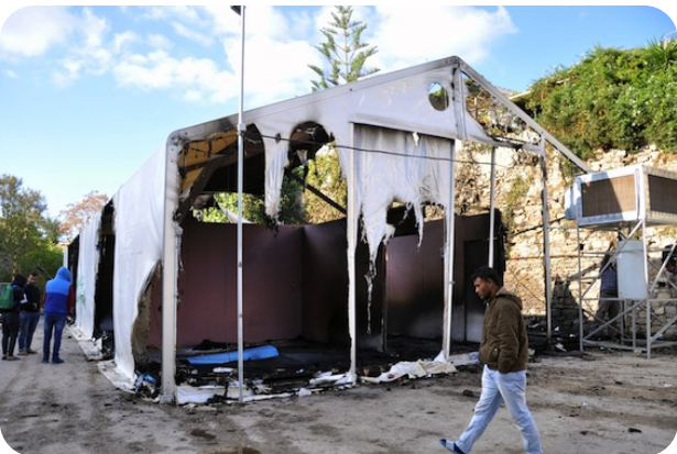
Estat de la carpa principal de Souda després d'un atac feixista
